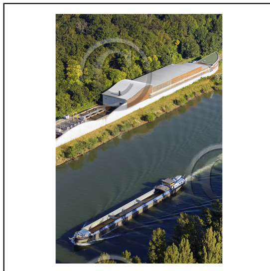
77 Seine-et-Marne Région Île-de-France / Avon : La station d'épuration de Fontainebleau Avon / La Seine
