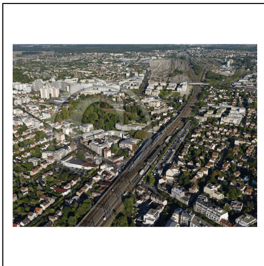
77 Seine-et-Marne Région Île-de-France / Chelles : Le quartier de la gare de Chelles-Gournay / Le projet du Grand Paris Express GPE ligne 16 avec la gare de Chelles / Perspective sur la gare de fret en arrière plan
