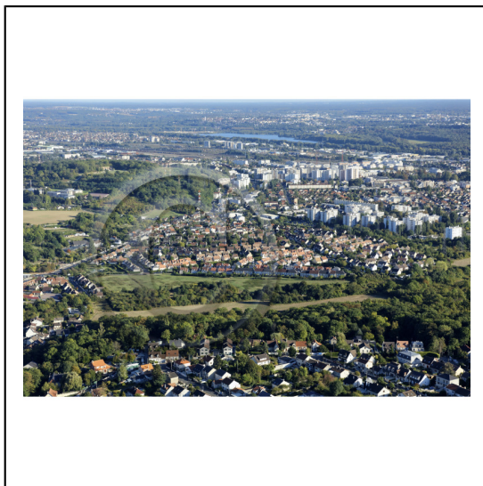
77 Seine-et-Marne Région Île-de-France / Chelles : Le secteur du Clos Roger / Le quartier du Bel Air / La route de Montfermeil à gauche de l'image
