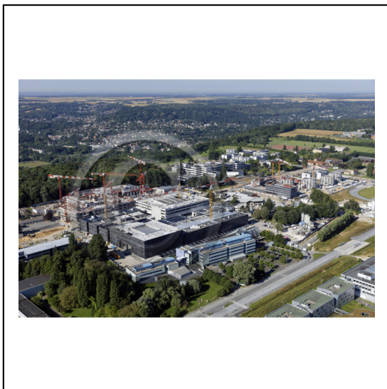
91 Essonne Région Île-de-France / Plateau de Saclay : Construction du projet urbain de Moulon / L'école Centrale Paris et l'institut de Biologie des Plantes à gauche de l'image (Quartier Joliot-Curie)
