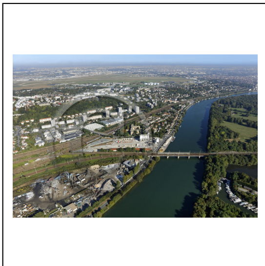
91 Essonne Région Île-de-France / Le viaduc SNCF entre Athis-Mons et Vigneux-sur-Seine / La Seine et le port aux cerises à Vigneux-sur-Seine sur la droite de l'image
