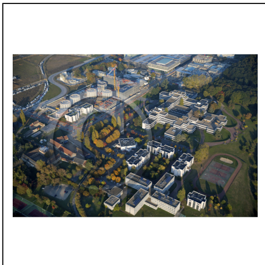
91 Essonne Région Île-de-France / Plateau de Saclay : Construction du projet urbain de Moulon / L'école Supélec en premier plan
