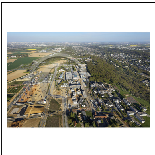
91 Essonne Région Île-de-France / Plateau de Saclay : Le campus urbain de Paris-Saclay / Construction du projet urbain de Moulon / L'école Supélec en premier plan et à droite de l'image *** Local Caption *** The plateau of Saclay: The urban project of Moulon in Gif-sur-Yvette (Urban Campus of Paris-Saclay) / 91 Essonne Région Île-de-France
