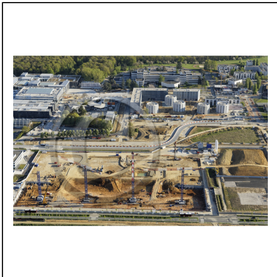
91 Essonne Région Île-de-France / Plateau de Saclay : Le campus urbain de Paris-Saclay / Construction du projet urbain de Moulon / L'école Supélec en arrière plan *** Local Caption *** The plateau of Saclay: The urban project of Moulon in Gif-sur-Yvette (Urban Campus of Paris-Saclay) / 91 Essonne Région Île-de-France
