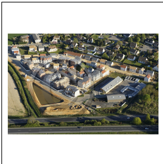
91 Essonne Région Île-de-France / Construction de nouveaux logements dans le village de Saclay / La RN118 *** Local Caption *** Housing buildings under construction in the village of Saclay / 91 Essonne Région Île-de-France
