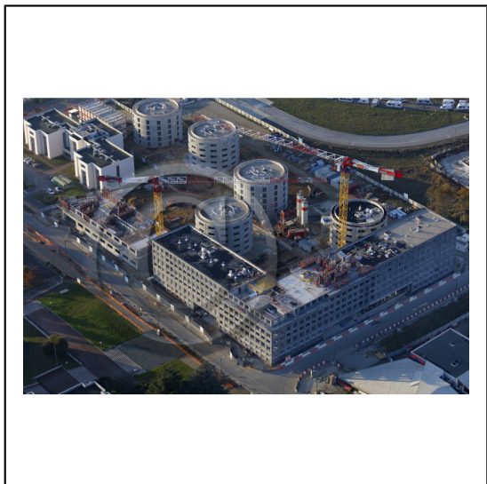
91 Essonne Région Île-de-France / Plateau de Saclay : Construction du projet urbain de Moulon
