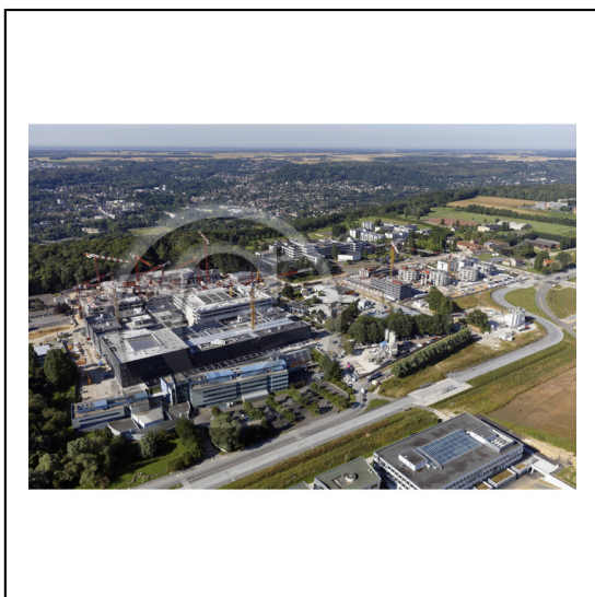
91 Essonne Région Île-de-France / Plateau de Saclay : Construction du projet urbain de Moulon / L'école Centrale Paris et l'institut de Biologie des Plantes à gauche de l'image
