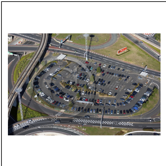
91 Essonne Région Ile-de-France / Parking dans l'aéroport d'Orly
