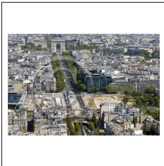
Paris 16/17 : La place de la Porte Maillot / Travaux de construction de la gare Porte Maillot ligne Eole E / Avenue de la Grande Armée / La place Charles de Gaulle avec l'Arc de Triomphe en arrière plan *** Local Caption *** Paris 16/17: The new railway station Porte Maillot under construction / Avenue de la Grande Armée
