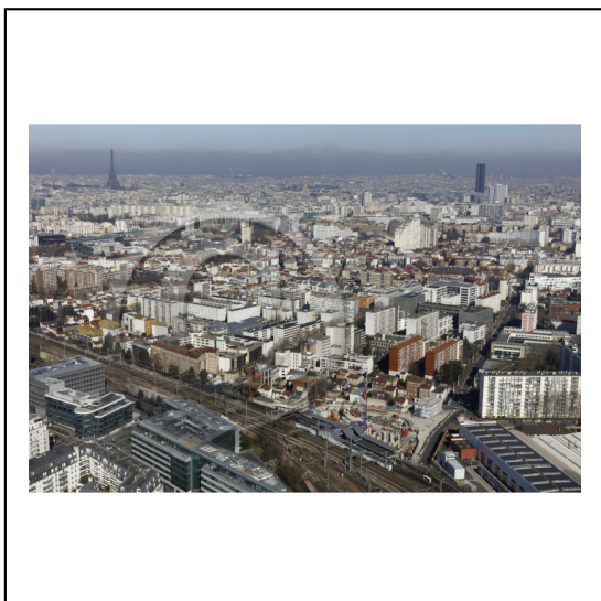
92 Hauts-de-Seine Région Île-de-France / Montrouge/Châtillon : Travaux de construction de la gare de Châtillon - Montrouge du Grand Paris Express GPE ligne 15 / La gare SNCF de Châtillon - Montrouge / Paris en arrière plan *** Local Caption *** Clamart/Vanves: The new railway station Châtillon - Montrouge under construction / The project GPE Grand Paris Express line 15/ The railway station SNCF Châtillon - Montrouge / Paris in back ground / 92 Hauts-de-Seine Région Île-de-France
