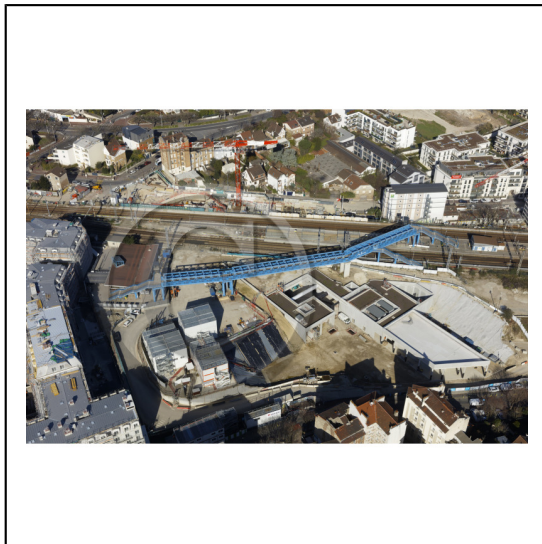
92 Hauts-de-Seine Région Île-de-France / Clamart/Vanves : Travaux de construction de la gare Fort d'Issy-Vanves-Clamart du Grand Paris Express GPE ligne 15 / La gare SNCF de Clamart *** Local Caption *** Clamart/Vanves: The new railway station Fort d'Issy-Vanves-Clamart under construction / The project GPE Grand Paris Express line 15/ The railway station SNCF Clamart à Vanves / 92 Hauts-de-Seine Région Île-de-France
