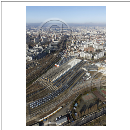
92 Hauts-de-Seine Région Île-de-France / Châtillon : Les ateliers SNCF *** Local Caption *** Châtillon: the workshop SNCF / 92 Hauts-de-Seine Région Île-de-France
