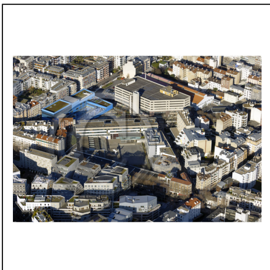
92 Hauts-de-Seine Région Île-de-France / Boulogne-Billancourt : L'école Pilote du Numérique dans le secteur Trapèze Est *** Local Caption *** Boulogne-Billancourt: The school "Ecole Pilote du Numérique" in the area "Trapèze East" / 92 Hauts-de-Seine Région Île-de-France
