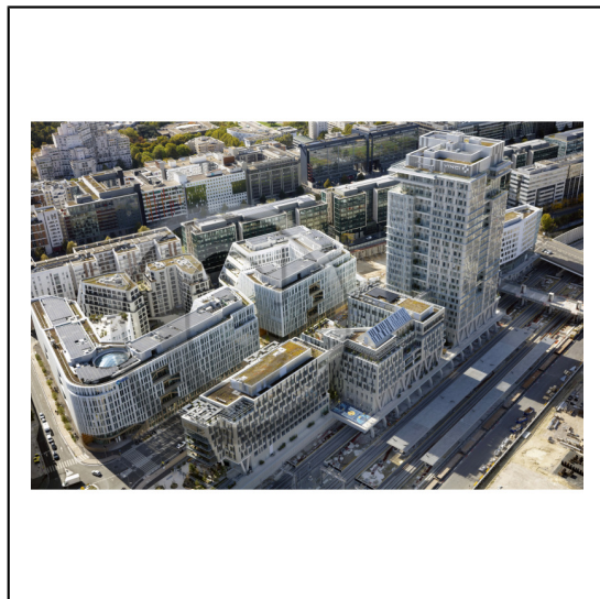
92 Hauts-de-Seine Région Île-de-France / Nanterre : Le site Archipel (J.P. Viguier & M. Mimram architectes 2021), siège social de Vinci dans le secteur des Terrasses de Nanterre et la future gare Nanterre La Folie du Grand Paris Express GPE ligne 15 / L'immeuble Origine ? gauche de l'image *** Local Caption *** City of Nanterre: The headquarter Vinci (design by J.P. Viguier & M. Mimram architects 2021) and the GPE Grand Paris Express line 15 with the future railway station Nanterre La Folie / 92 Hauts-de-Seine Région Île-de-France
