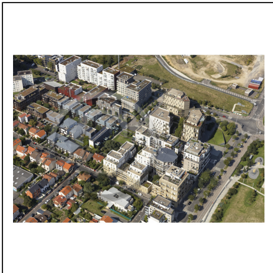
92 Hauts-de-Seine Région Île-de-France / Nanterre : Le secteur Rouget de Lisle
