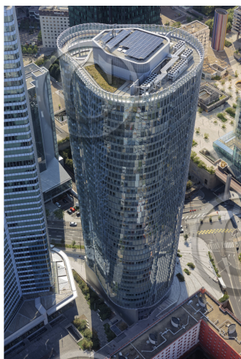
92 Hauts-de-Seine Région Île-de-France / Paris la Défense : La tour Alto (Interface/SRA architectes 2019) / La Défense, secteur Esplanade Nord
