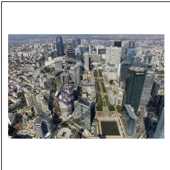
92 Hauts-de-Seine Région Île-de-France / Paris la Défense : Le quartier Esplanade Sud et Michelet Galliéri / Construction des tours "The Link" (PCA Stream - Ph.Chiambaretta Architecte) / Le chantier Lightwell en deuxième plan / La Grande Arche de la Défense en arrière plan / L'Axe Historique et l'esplanade du Général de Gaulle
