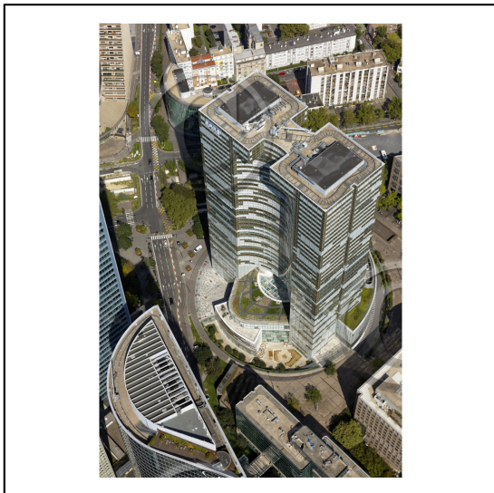
92 Hauts-de-Seine Région Île-de-France / Paris la Défense, secteur Esplanade Nord : la tour Descartes-Eqho (Architecte Willerval 1987)
