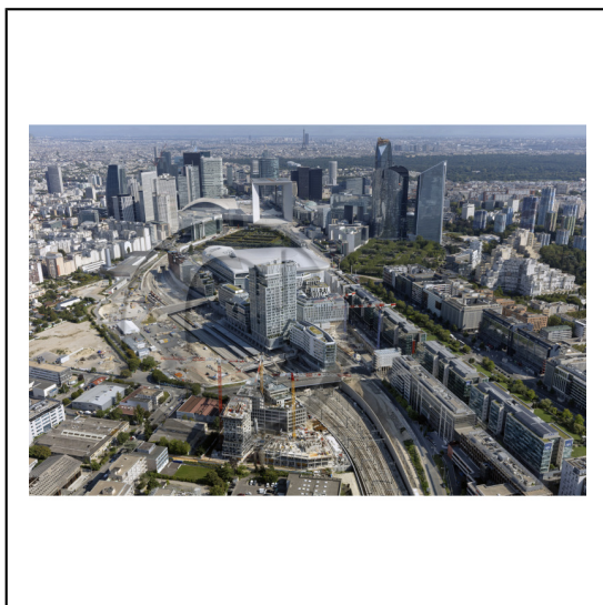
92 Hauts-de-Seine Région Île-de-France / Nanterre : Construction du programme mixte bureaux et logements "Hélios" (Nicolas Laisné Architectes/A26/Becardmap/Aqma/Migo - Panhard et Bricqueville) dans le secteur des Groues en bas de l'image / Le site Archipel (Siège Social de Vinci) et le site de la future gare Nanterre La Folie du Grand Paris Express GPE ligne 15 en deuxième plan / Paris et le quartier de la Défense en arrière plan
