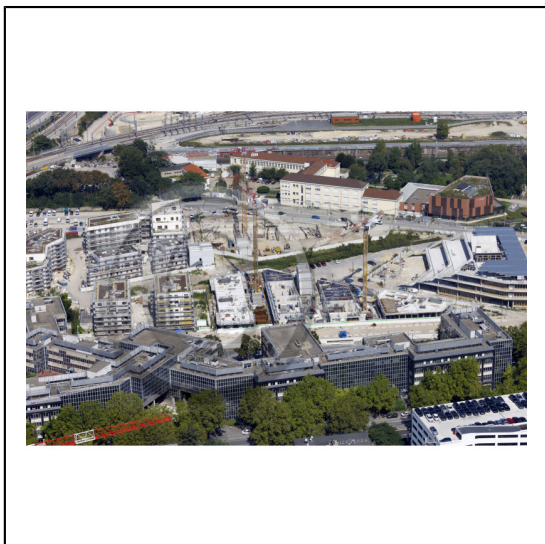
92 Hauts-de-Seine Région Île-de-France / Nanterre : Construction du programme "West Village" (L'AUC/Martin Duplantier/Chartier Dalix/Studio Muoto/Ignacio Prego architectes - Marignan) dans le secteur des Groues
