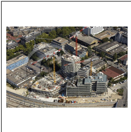
92 Hauts-de-Seine Région Île-de-France / Nanterre : Construction du programme mixte bureaux et logements "Hélios" (Nicolas Laisné Architectes/A26/Becardmap/Aqma/Migo - Panhard et Bricqueville) dans le secteur des Grooves
