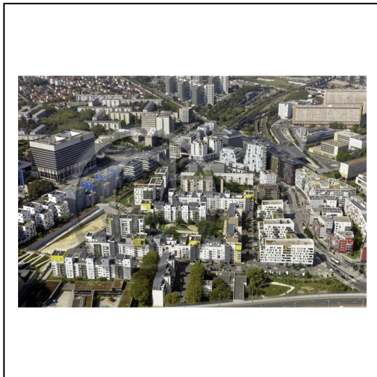
92 Hauts-de-Seine Région Île-de-France / Nanterre : Le quartier de la gare de Nanterre Université / Le secteur Coeur de Quartier en premier plan
