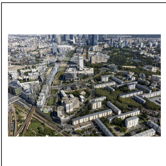
92 Hauts-de-Seine Région Île-de-France / Nanterre : La Cité Marcellin Berthelot en premier plan / Perspective sur les Terrasses de Nanterre, le secteur de la Préfecture de Nanterre et le quartier de la Défense en arrière plan
