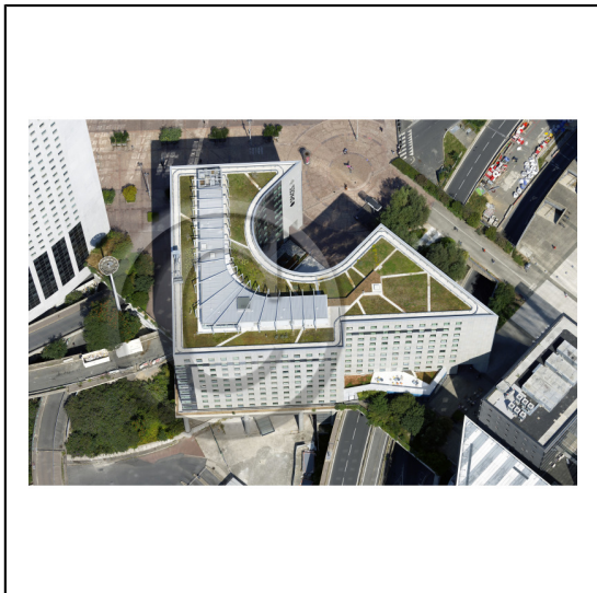
92 Hauts-de-Seine Région Île-de-France / Puteaux : Immeuble de Coworking "Spaces - La Défense"
