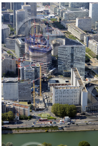
92 Hauts-de-Seine Région Île-de-France / Paris la Défense : Le quartier Esplanade Sud et Michelet Galliéni / Construction des tours "The Link" (PCA Stream - Ph.Chiambaretta Architecte) / L'immeuble Lightwell (B.Architecture) en arrière plan / Le secteur Bellini / Perspective sur l'Axe de la Défense
