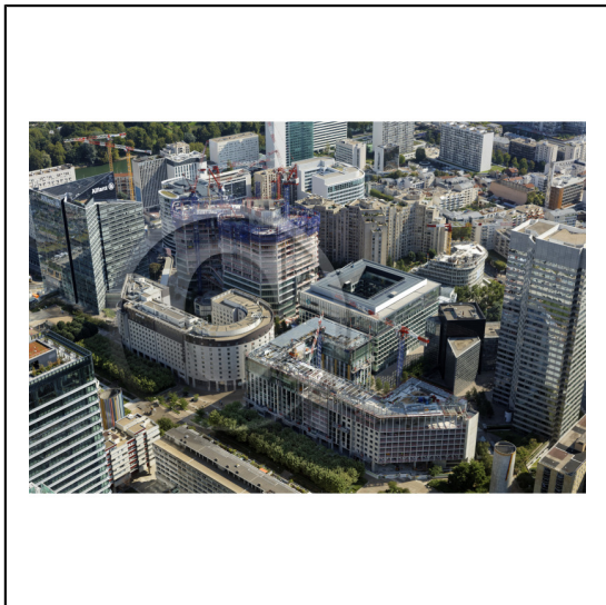
92 Hauts-de-Seine Région Île-de-France / Puteaux : Le chantier Lightwell (B.Architecture) en premier plan / Les tours "The Links" en construction en deuxième plan / La Défense secteur Esplanade Sud
