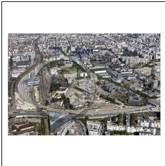
92 Hauts-de-Seine Région Île-de-France / Nanterre : Le secteur des Groues / Construction du programme "West Village" (L'AUC/Martin Duplantier/Chartier Dalix/Studio Muoto/Ignacio Prego architectes - Marignan) / Perspective sur La Garenne-Colombes en arrière plan
