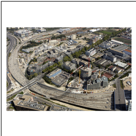
92 Hauts-de-Seine Région Île-de-France / Nanterre : le secteur des Grooves / Construction du programme mixte bureaux et logements "Hélios" (Nicolas Laisné Architectes/A26/Becardmap/Aqma/Migo - Panhard et Bricqueville) en premier plan
