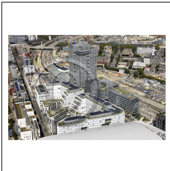
92 Hauts-de-Seine Région Île-de-France / Nanterre : L'immeuble de bureaux Origine et l'immeuble Archipel (J.P. Viguier & M. Mimram architectes 2021), siège social de Vinci.
