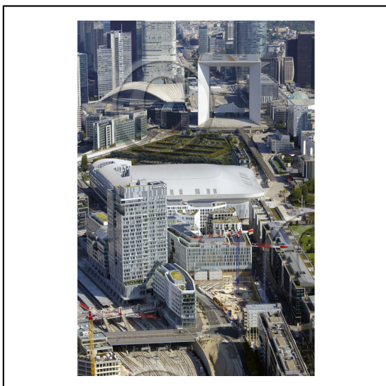
92 Hauts-de-Seine Région Île-de-France / Nanterre : Le site Archipel (Siège Social de Vinci) et le site de la future gare Nanterre La Folie du Grand Paris Express GPE ligne 15 en premier plan / Les sites Paris la Défense Aréna et la Grande Arche de la Défense en arrière plan
