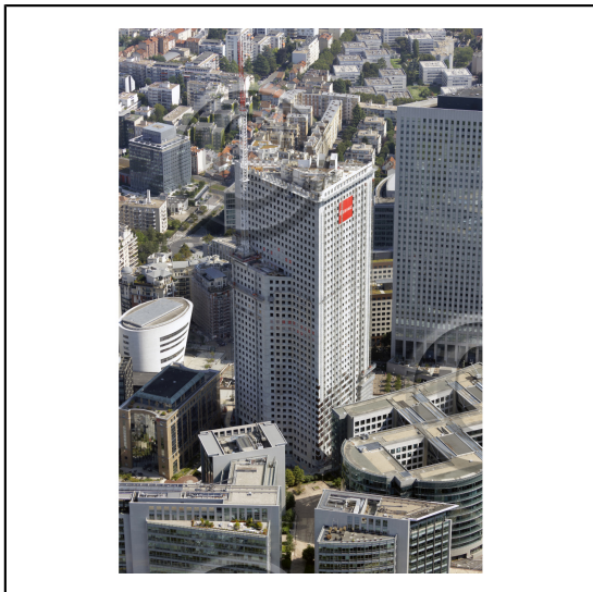
92 Hauts-de-Seine Région Île-de-France / Paris la Défense : Rénovation de la tour Adria, rebaptisée tour Hopen (Jean Mas / Ateliers 2/3/4 / CHZON architectes)
