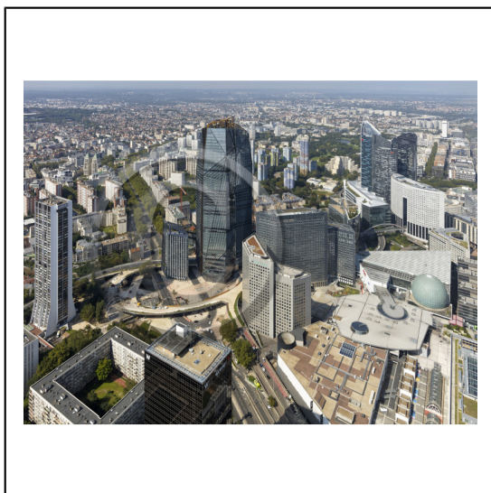
92 Hauts-de-Seine Région Île-de-France / Paris la Défense : Le secteur Arche Sud / La tour Hekla (Ateliers Jean Nouvel architectes) et le secteur de la Rose de Cherbourg / Vue depuis le quartier des Degrés en premier plan
