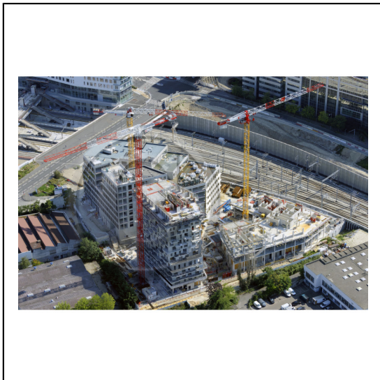
92 Hauts-de-Seine Région Île-de-France / Nanterre : Construction du programme mixte bureaux et logements "Hélios" (Nicolas Laisné Architectes/A26/Becardmap/Aqma/Migo - Panhard et Bricqueville) dans le secteur des Groues
