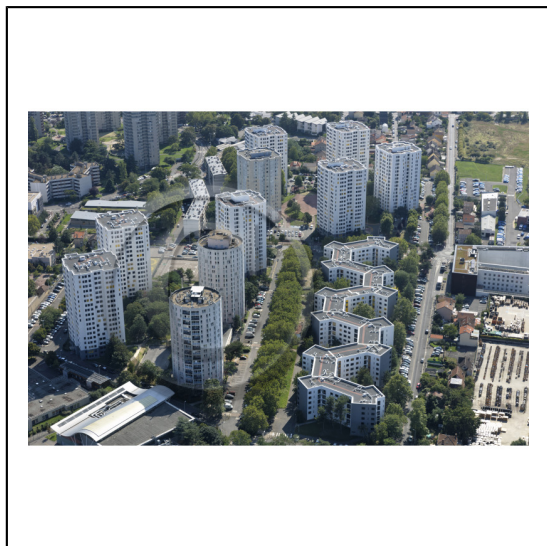
92 Hauts-de-Seine Région Île-de-France / Nanterre : Le quartier du Chemin de l'Île / L'allée des Erables
