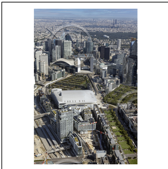
92 Hauts-de-Seine Région Île-de-France / Nanterre : le quartier des Terrasses de Nanterre / Les immeubles Archipel (J.P. Viguier & M. Mimram architectes 2021), siège social de Vinci et la future gare Nanterre La Folie du Grand Paris Express GPE ligne 15 en premier plan / Le site Paris la Défense Arena en deuxième plan / Le quartier d'affaires de la Défense avec la Grande Arche de la Défense, et Paris en arrière-plan / Le chantier de construction Défense 2 - Edenn (Brenac et Gonzalez architectes - Icade) en bas de l'image
