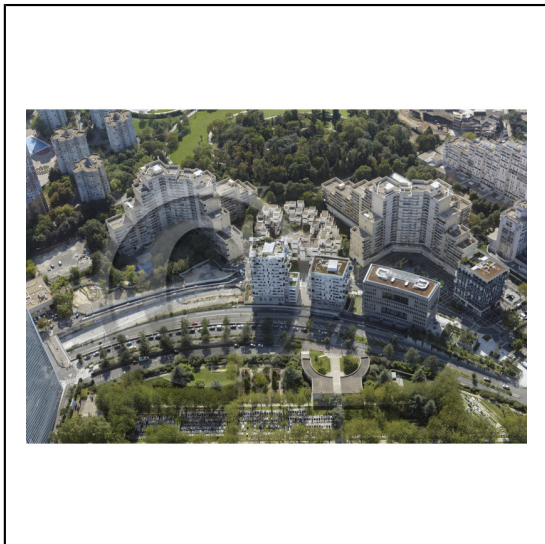
92 Hauts-de-Seine Région Île-de-France / Nanterre : le secteur du Croissant
