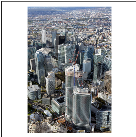
92 Hauts-de-Seine Région Île-de-France / Paris la Défense : Le quartier Esplanade Sud et Michelet Galliéni / Construction des tours "The Link" (PCA Stream - Ph.Chiambaretta Architecte)
