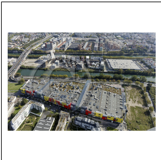
92 Hauts-de-Seine Région Île-de-France / Villeneuve-la-Garenne : Le centre commercial Quartz boulevard Galliéni en premier plan / Quai du Moulin de Cage / L'île Saint-Denis et le site des JO Paris 2024 en arrière plan
