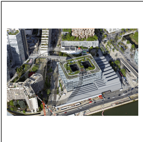
92 Hauts-de-Seine Région Île-de-France / Boulogne-Billancourt : l'immeuble Métal 57 / La rue du Vieux Pont de Sèvres / Le quai Georges Gorse
