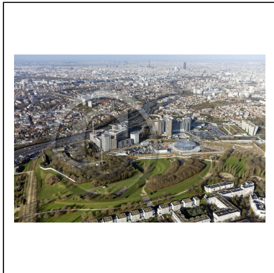
94 Val-de-Marne Région Ile-de-France / Villejuif : Travaux de construction de la gare de Villejuif Institut Gustave Roussy du Grand Paris Express GPE ligne 15 / L'Institut Gustave Roussy / Paris en arrière plan
